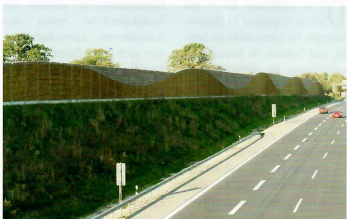
Bild 2: Gerade Wand mit Wellen
