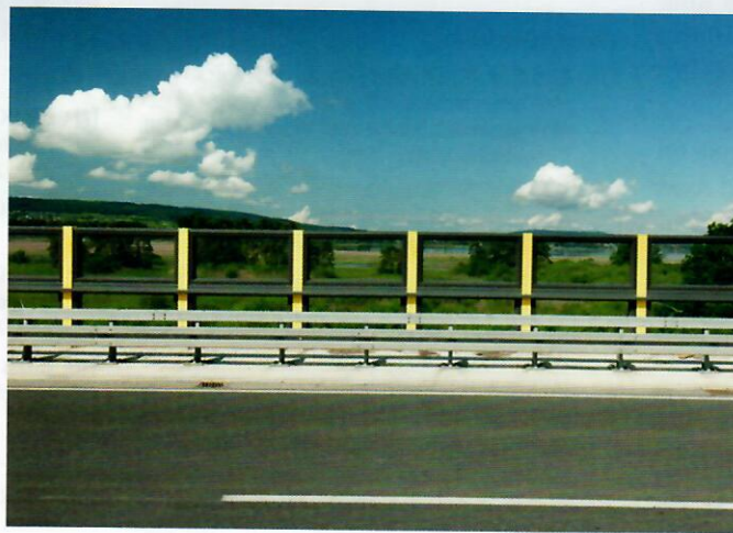
Bild 1: Hybride Lärmschutzwände verbinden freie Sicht mit Lärmschutz (Foto: R. Kohlhauser GmbH)
