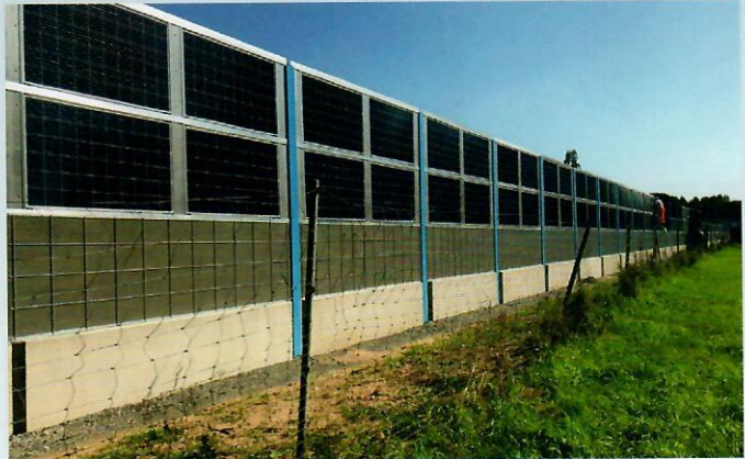
Bild 2: Photovoltaik-Lärmschutzwand in Aschaffenburg (Foto: Frank Treiber, Ing.-Büro Treiber Umweltconsulting)
