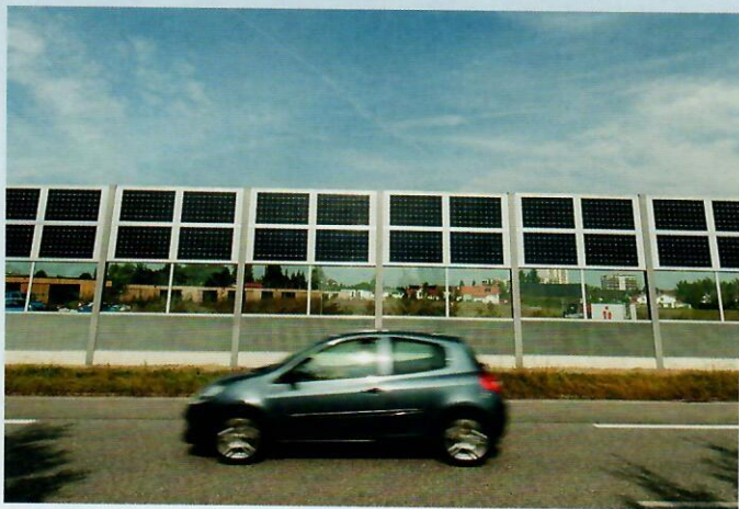
Bild 3: Photovoltaik-Lärmschutzwand in Neuötting (Foto: R. Kohlauer GmbH)
