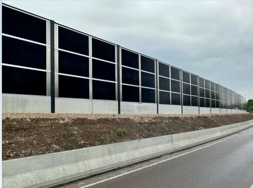
Bild 3: Fertiggestellte PV-Lärmschutzwand
