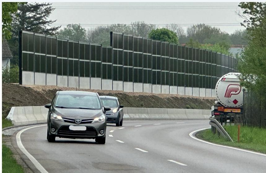
Bild 4: PV-Lärmschutzwand Waltershofen unter Verkehr
