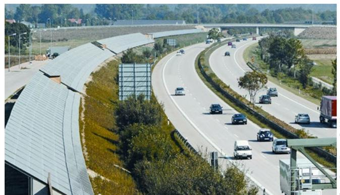
Bild 6 Pv-Lsw Freising – Konzeptionsmodell
